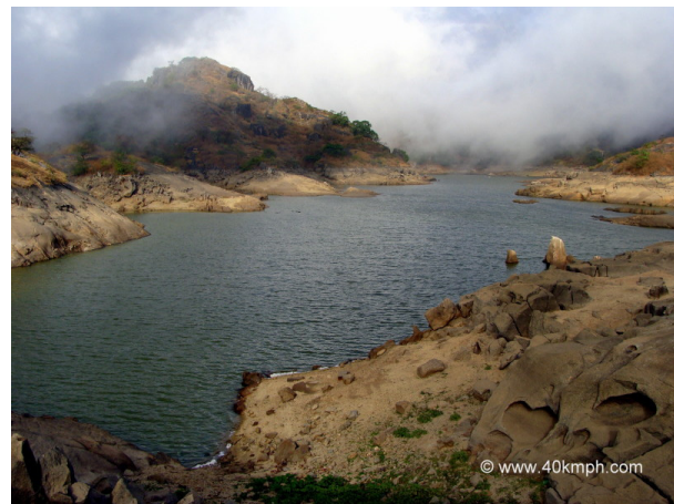
Fig. 1. Upper Kodra Dam
